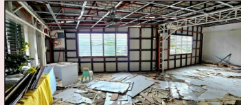
Alle Wände wurden entfernt
