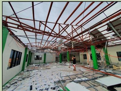
Die Einweihung der Bibelschule ACTS liegt noch nicht so lange zurück (Ende 2019), aber durch die Kraft des Taifuns ist das oberste Stockwerk stark beschädigt worden und das Dach ist weggefliegen.
